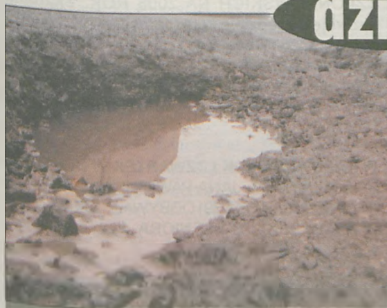
DROGA KRAJOWA NR 12 odcinek od torów kolejowych w Brzostowie, prawa strona w kierunku Jarocina Administrator: Poznański oddział Generalnej Dyrekcji Dróg Krajowych i Autostrad
