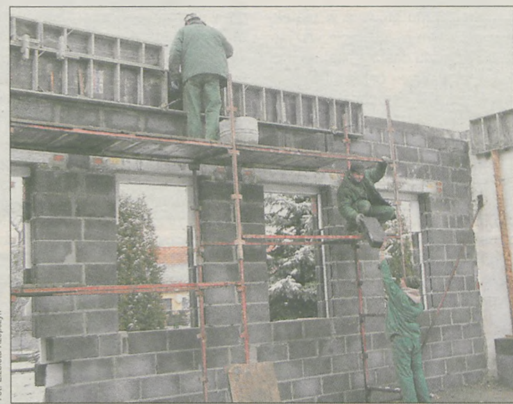
OD TRZECH TYGODNI trwa budowa remizy w Tarcach
