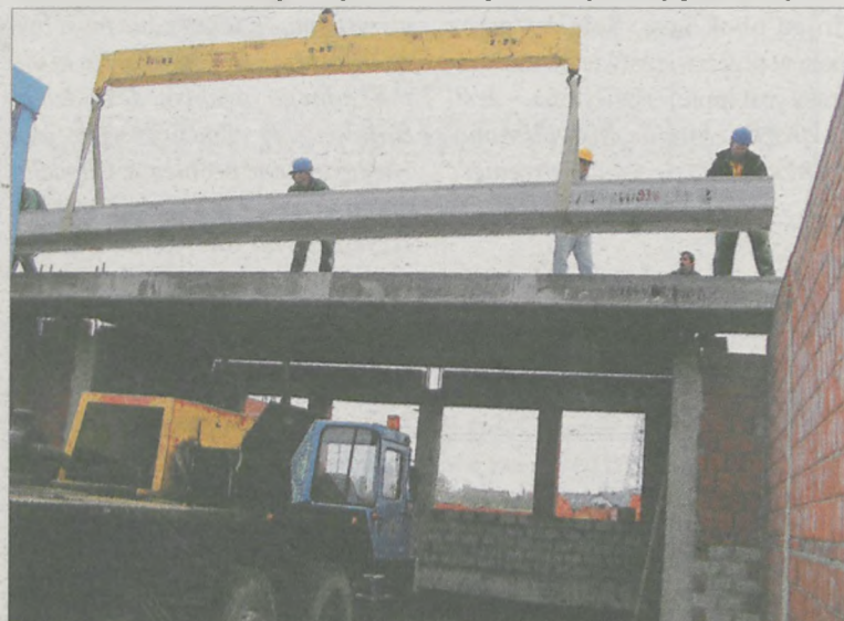
STROP ZOSTAŁ POŁOŻONY NA 2/3 POWIERZCHNI CAŁEGO OBIEKTU. Pozostała część betonowych płyt ma się pojawić w przyszłym roku. Zdaniem proboszcza - księdza Andrzeja Piłata trudno jest określić, ile lat potrzeba na dokończenie budowy świątyni.
