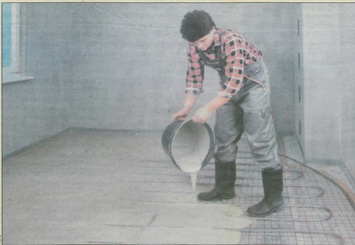
Pierwszą warstwę wylewki wykonujemy tak, aby lekko przykryła przewody grzewcze
