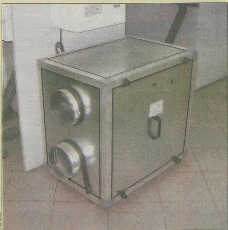
Centrala wentylacyjna z nagrzewnicą wodną
