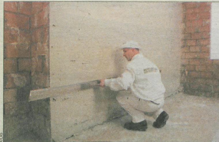
Dokładność i staranność gipsowania zaowocuje równymi ścianami
