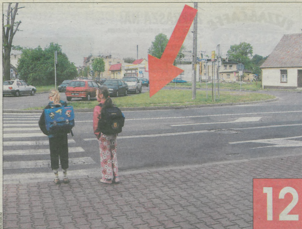
Obecne skrzyżowanie ul. Ostrowskiej i al. Powstańców Wlkp. Tutaj powstanie nowa jezdnia, rozpoczynająca aleję
