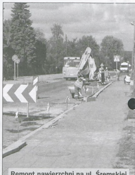
Remont nawierzchni na ul. Śremskiej w Mosinie
