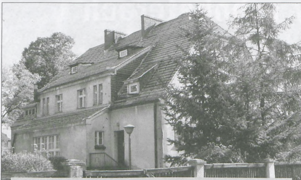
Przedszkole nr 4 zyskało nowy dach
