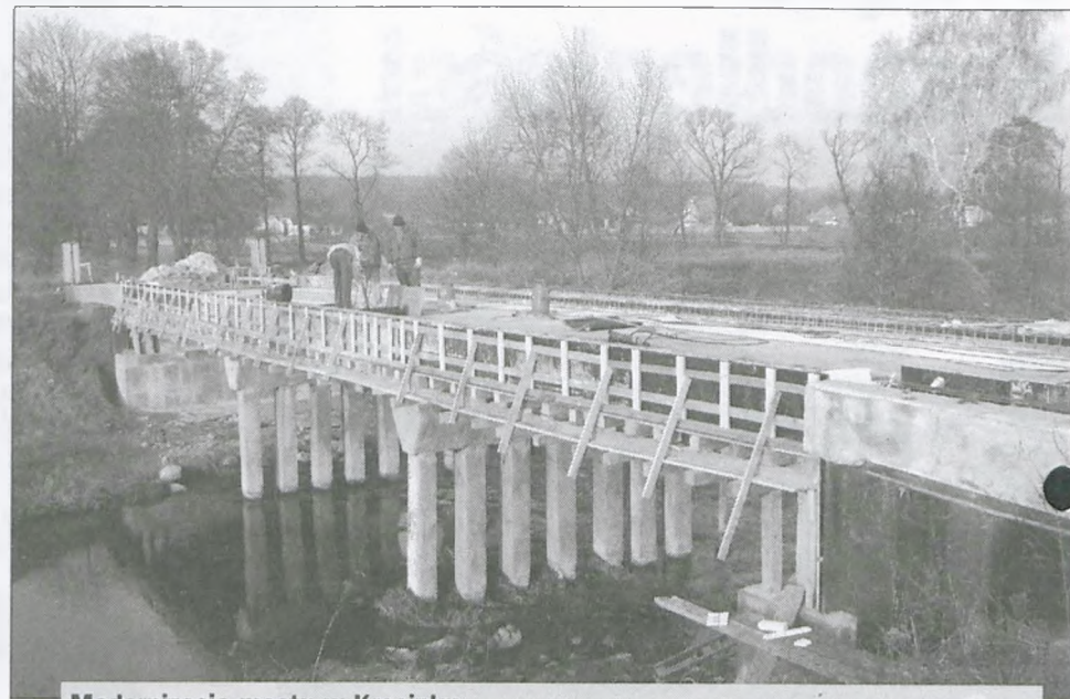
Modernizacja mostu w Krosinku
