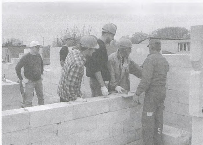
Budowa kolejnego budynku mieszkalnego Habitatu w Sadach k/Poznańa Foto: HfH
