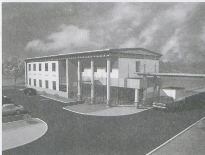
Jest szansa, że jeszcze w tym roku tym wejściem do pracy udawać się będą pierwsi pracownicy Zakładu INTERCELL S.A. w Mosinie
