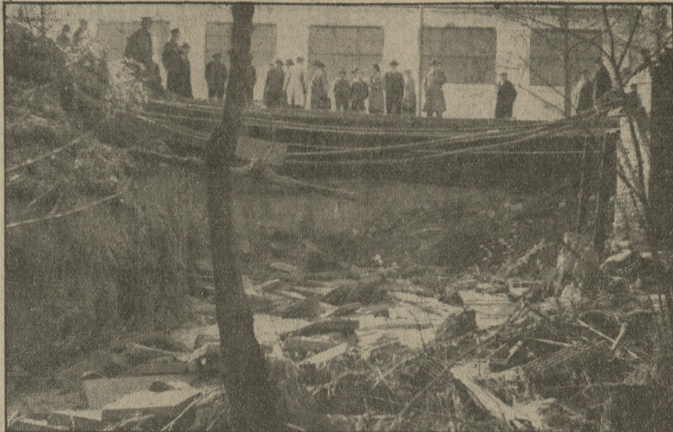
Katastrofalne skutki wtorkowej ulewy w Poznaniu. Olbrzymia wyrwa na ul. Marsz. Focha w pobliżu wylotu ul. Bukowskiej, gdzie został zerwany chodnik i część jezdni na przestrzeni 16 metrów.
