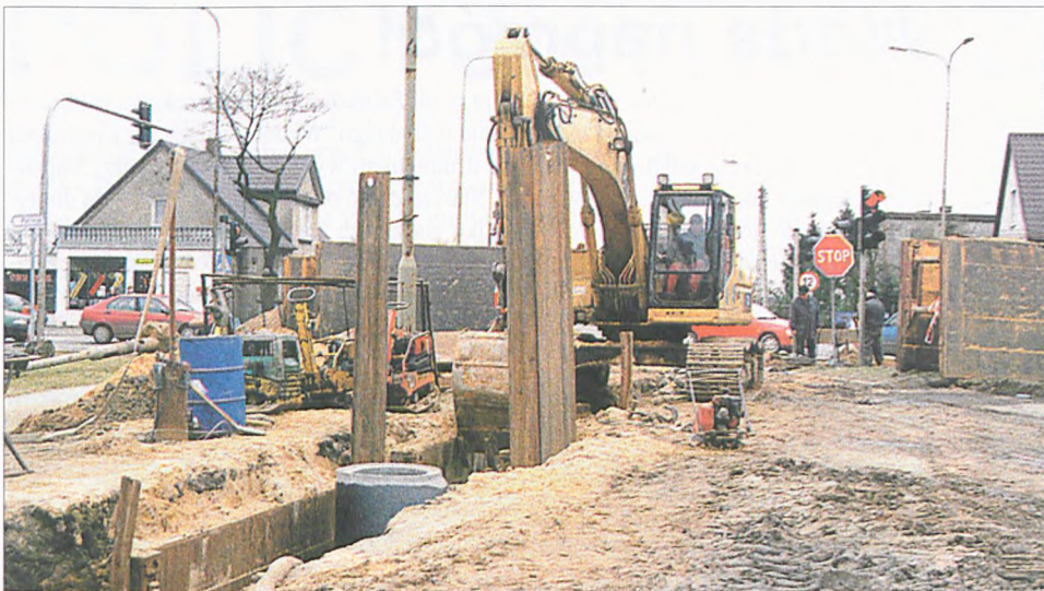
Tym razem przez skrzyżowanie przeprowadzana jest kanalizacja sanitarna. Przed wojną w tym miejscu był stawek, pastwisko i małe targowisko. W planach - po przeciwnej stronie skrzyżowania, budowane będzie Centrum Lubonia.
