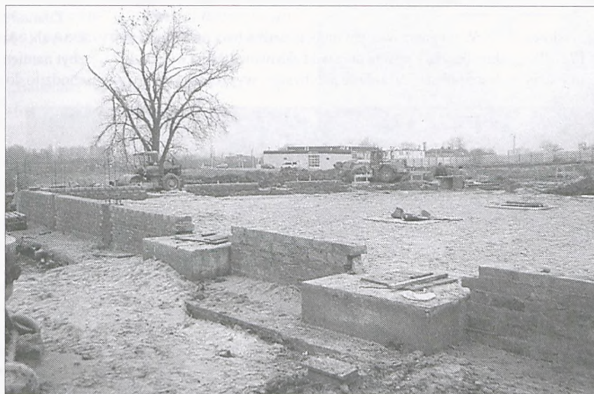
W grudniu, zgodnie z planem, ruszyła budowa fundamentów. Widok od strony ul. Źródlanej, w głębi stacja paliw DEA.
