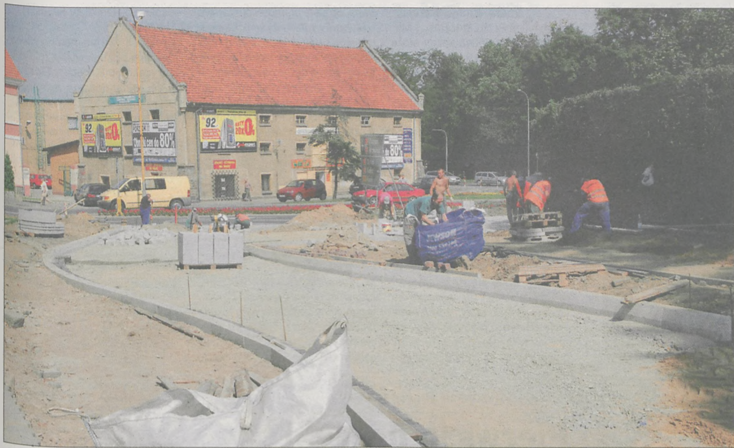
Chodniki na ulicach Kardynała Wyszyńskiego i Gołębiej będą wyłożone płytkami granitowymi. Nawierzchnia dróg - kostką brukową
