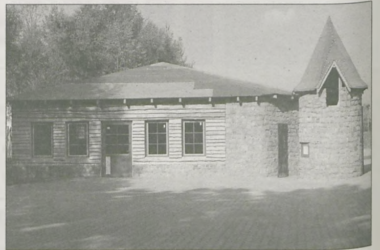
ŁOWISKO SABAT przy oczyszczalni w Cielczy i niewykończony budynek restauracji przejęło Przedsiębiorstwo Wodociągów i Kanalizacji w Jarocinie za 260 tys. zł.
