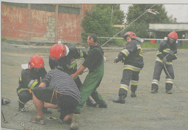
Pochylający się zbiornik ratownicy zabezpieczyli stalowymi linami
