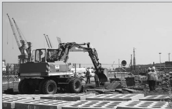
Dobiegają końca prace remontowe nabrzeży i placów portowych na terenie WOC-u.
