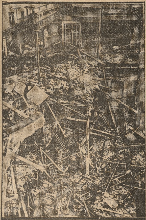
POZAR NAJWIEKSZEGO DOMU TOWAROWEGO W BARCELONIE.
