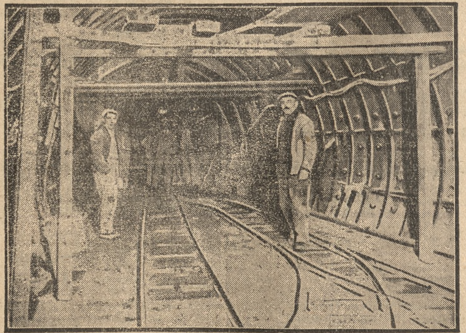
BUDOWA OLBRYZMIEGO TUNELU.
