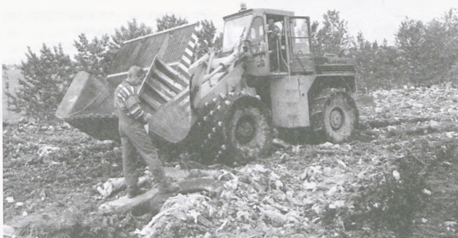
Ponad ciężarem ponad 20-tonowej maszyny góra śmieci obniżyła się o ok. 30 cm.
