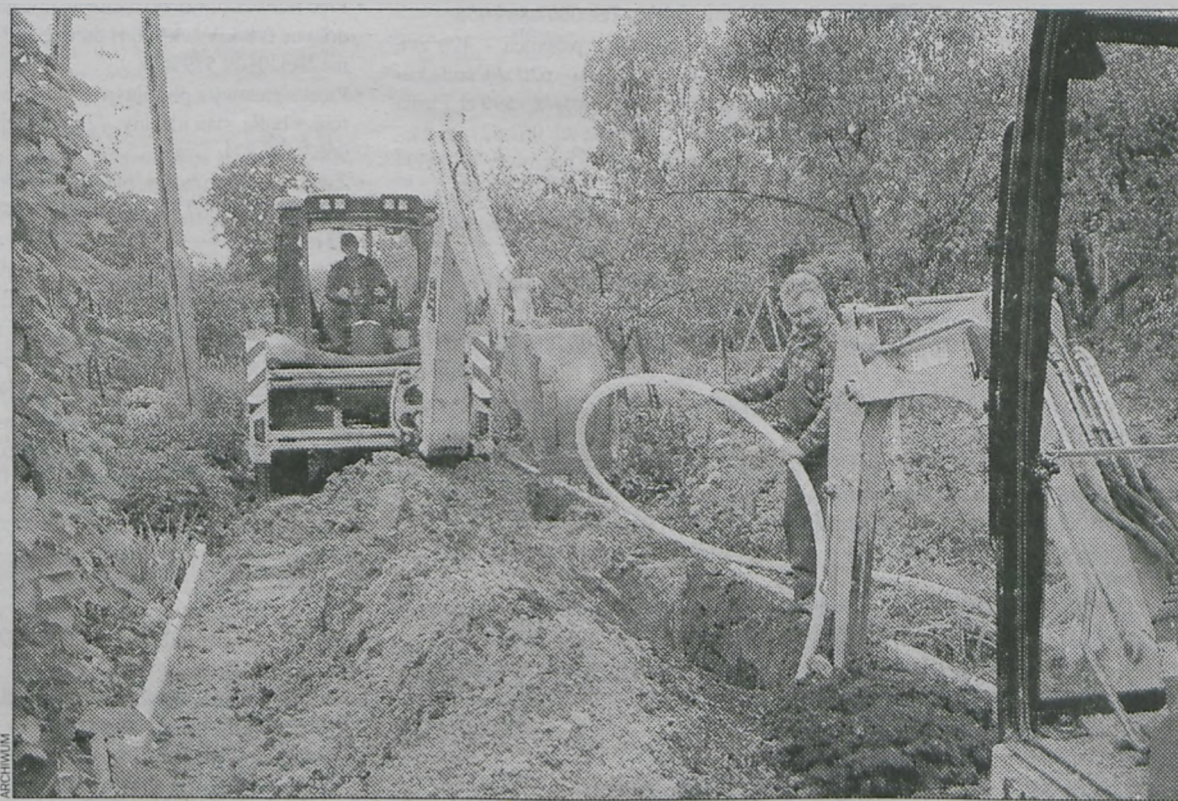
Prace przeprowadzono szybko i fachowo
