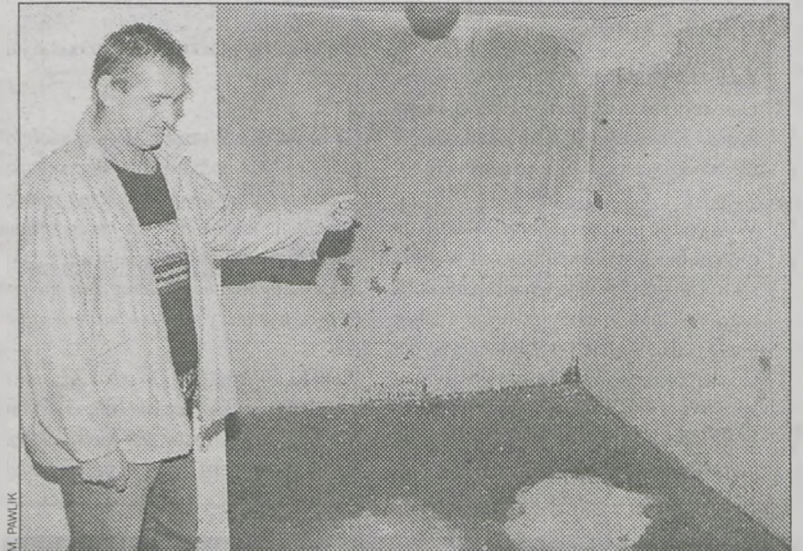
Pomieszczenie trzeba jeszcze pomalować – mówi J. Walczak
