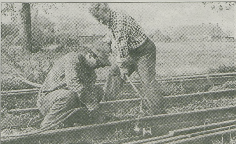
Październik 1993 r. Demontaż torowiska wąskotorówki koło Wziachowa Wielkiego
