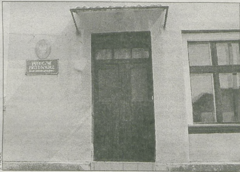
W przedszkolu zostaną wymienione drzwi wejściowe i okna
