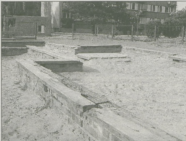
Na obrzeżach piaskownicy brakuje drewnianych siedzisk, wystają również gwoździe!
