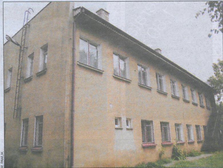
Dom Rolnika w Bożacinie miałby zostać rozbudowany
