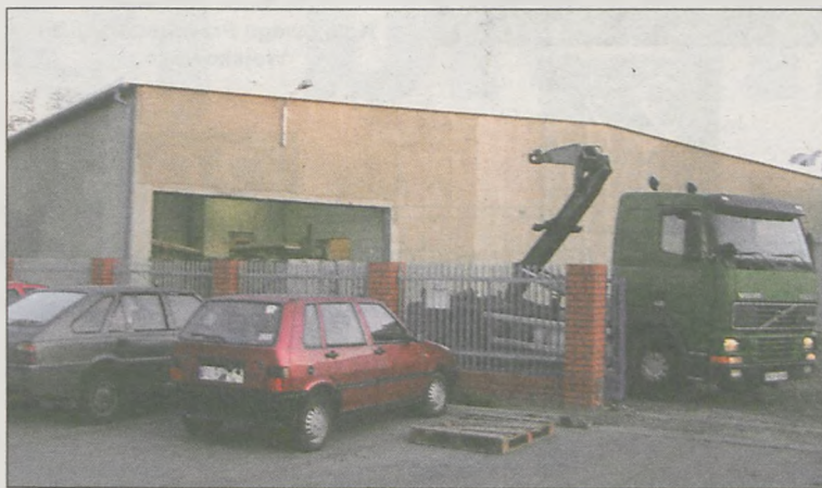
BUDYNEK miał być przeznaczony na magazyn opakowań. Właściciel firmy chce zaadaptować obiekt na halę rozbioru i pakowania mięsa. Czekają na decyzję ze starostwa.
