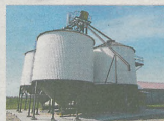
Linie technologiczne magazynów zbożowych
