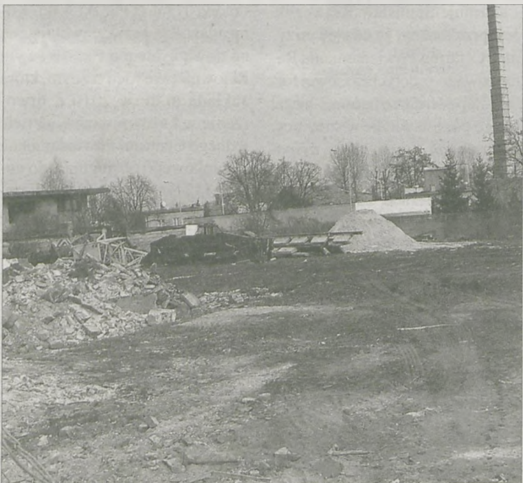
STAWIANIE BLOKU MIESZKALNEGO KOŁO SZPITALA Ryszard Grzebyszak zgodnie z obietnicą zaczyna z końcem marca. Do tej pory robotnicy wycięli drzewa, zburzyli jeden budynek i przygotowali teren pod budowę.
