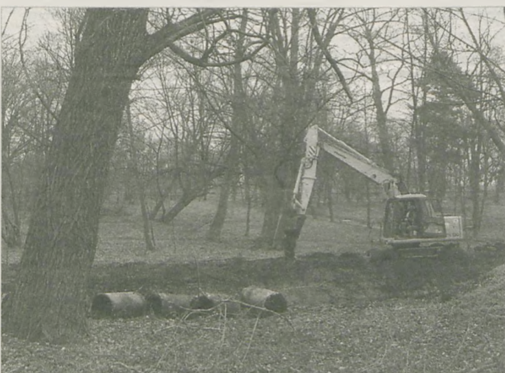
W PARKU należącym do Mickiewiczowskiego Centrum Turystycznego w Żerkowie trwają prace nad odbudową rowu
