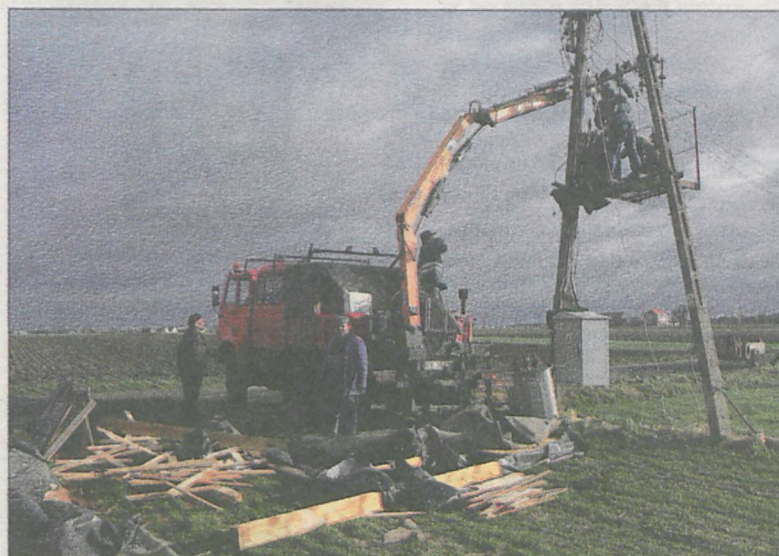
ZERWANE LINIE ENERGETYCZY naprawiali trzy dni
