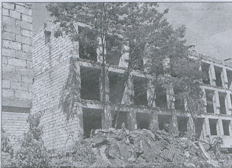
Starostwo wydało zgodę na rozbiórkę niedokończonych szkoły
