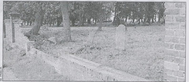
Murowany płot będzie zastąpiony metalowym
