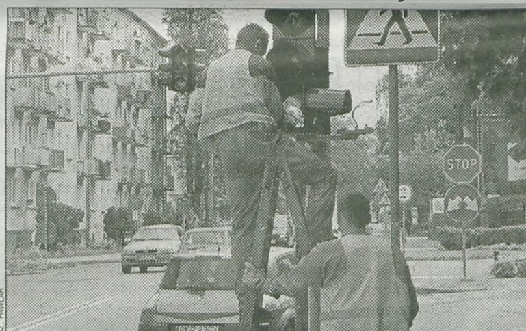
Firma skierowana do pracy przez GDDKiA odnowiła też pozostałe sygnalizatory
