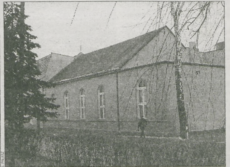
Strop popękał, ale dach jest nienaruszony
