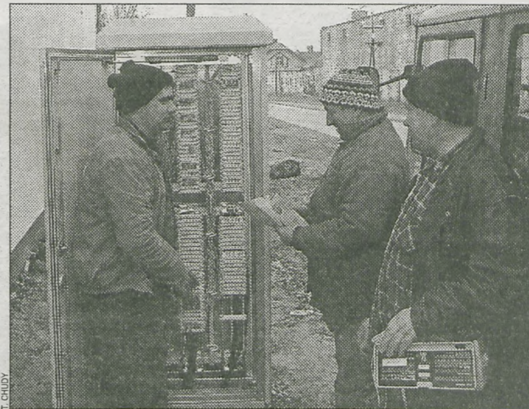
Instalatorzy przyłączają Baszków i okolice do nowej centrali
