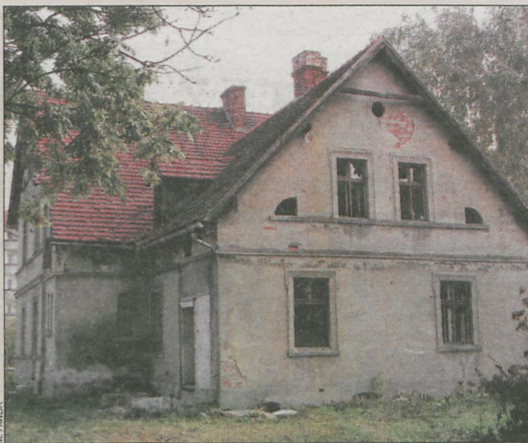
Stara rudera na działce przy Benickiej...
