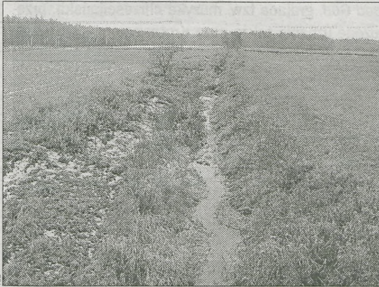
Zarośnięty Rów Baszkowski będzie wkrótce udrożniony
