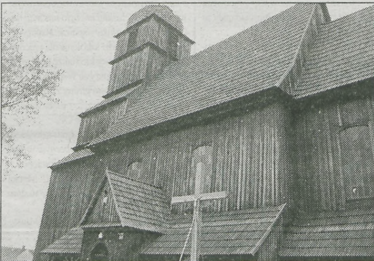
Do budowy kościoła użyto drewna modrzewiowego
