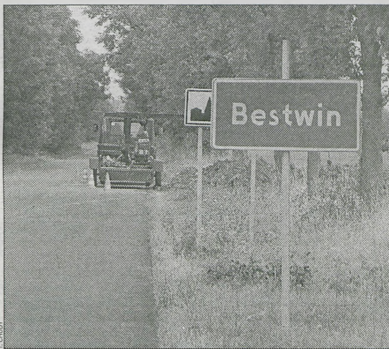
Nowy kabel jest instalowany między innymi w Bestwinie
