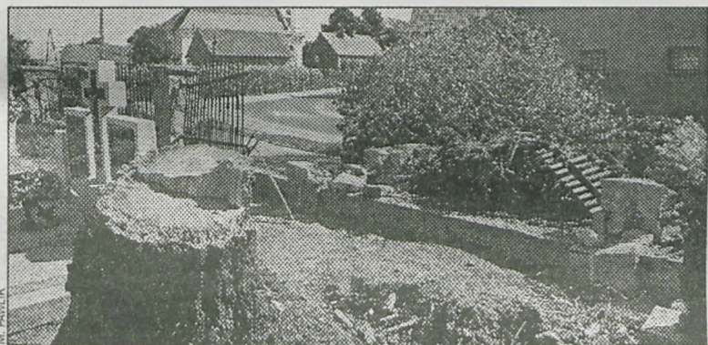
Drzewo zniszczyło część ogrodzenia
