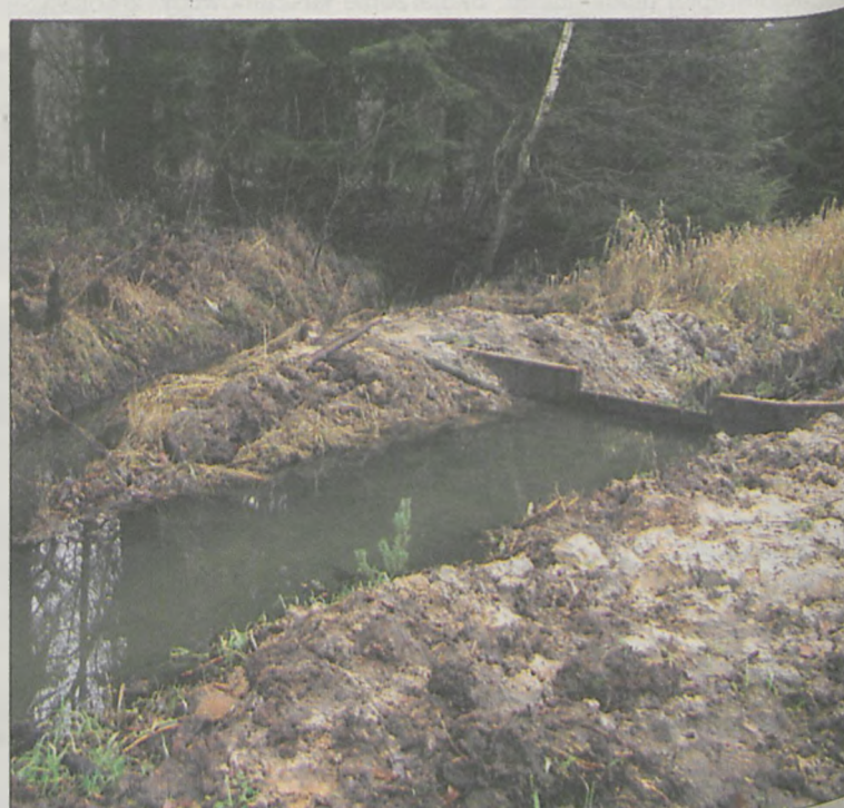
DREWNIANA ZASTAWKA WODNA piętrząca wodę na cieku wodnym, doprowadzająca ponadto wodę do lokalnego podtopienia
