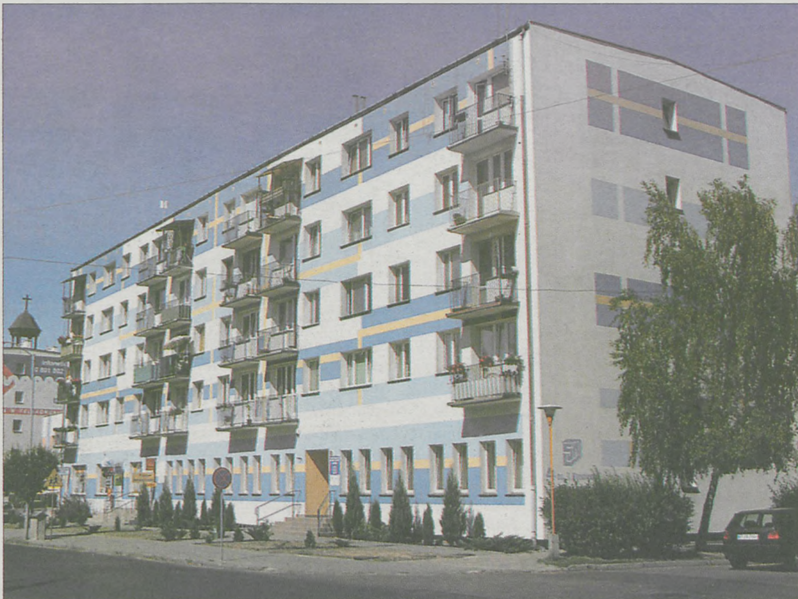
GDYBY DOSZŁO DO REALIZACJI PROJEKTU zmodernizowana zostałaby nie tylko kotłownia, ale i bloki należące do spółdzielni, jak ten przy ul. Kościuszki, w którym mieści się siedziba władz SML-W
