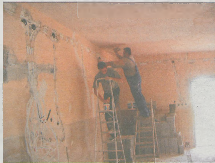
WEWNĄTRZ BUDYNKU wymieniana jest instalacja elektryczna
