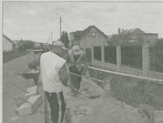
ZA MIESIĄC ma się zakończyć budowa chodnika na ul. Szkolnej w Noskowie
