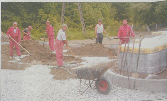
Trwa budowa kanalizacji deszczowej i nawierzchni z kostki na drogach dojazdowych do ulicy Prośnianej w Jarocinie. Inwestycja kosztuje 300 tys. zł i ma się zakończyć na początku lipca. (ag)
