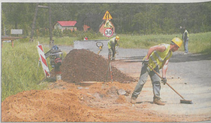
UTRUDNIENIA W RUCHU związane z budową kanalizacji wzdłuż drogi Annapol - Wilkowyja potrwać przynajmniej do końca czerwca
