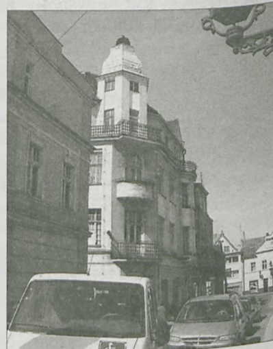
MIESZKAŃCY jarocińskiego Rynku i okolicznych ulic mają dosyć wycia syreny strażackiej, która zamontowana jest na budynku PKO.
