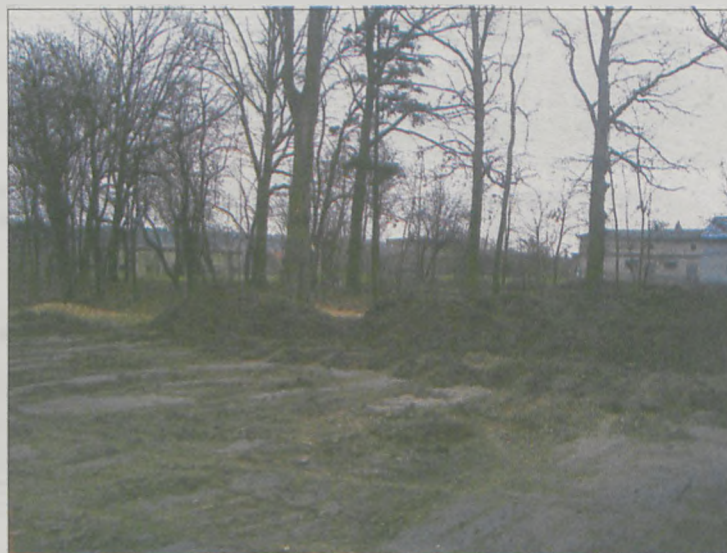
AKTUALNIE budowane jest boisko do piłki nożnej
