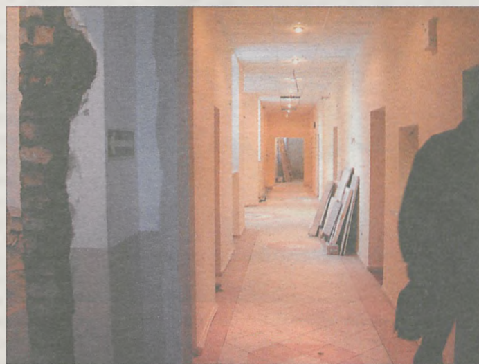
REMONT W SĄDZIE wciąż trwa. Tak wyglądają w tej chwili korytarze
