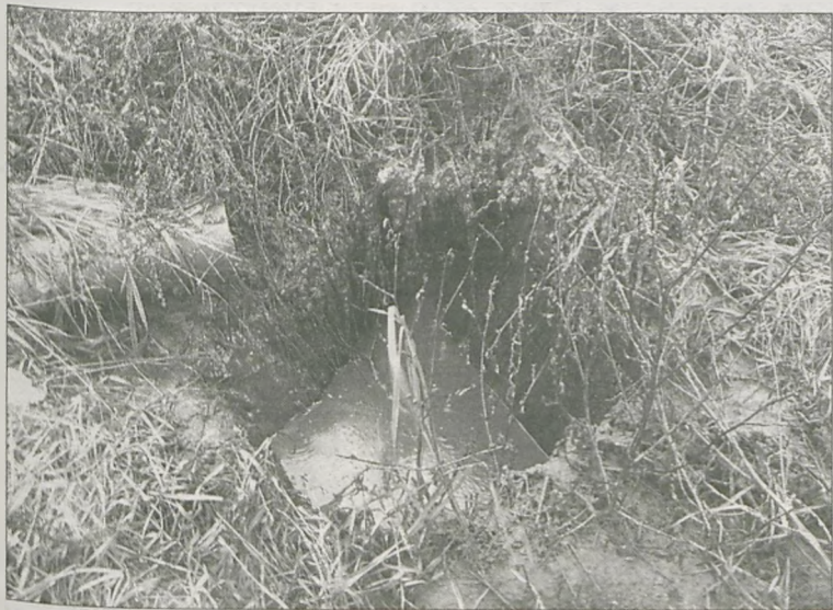
OSADY ŚCIEKOWE z oczyszczalni trafiały najpierw do niewielkiego dołu, a potem na poletka osadowe po drugiej stronie drogi prowadzącej z ul. Cmentarnej w Cielczy do lasu.
