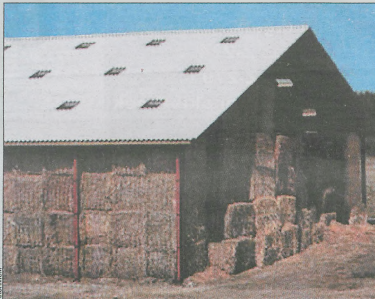
Wiaty z dachem wykonanym z włókno-cementowych płyt falistych i świetlików
