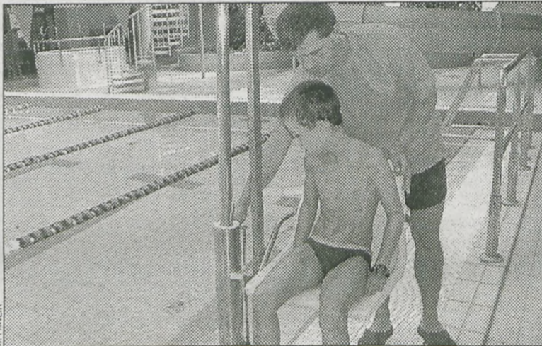
Basen dysponuje windą, która ułatwia niepełnosprawnym wejście do wody
