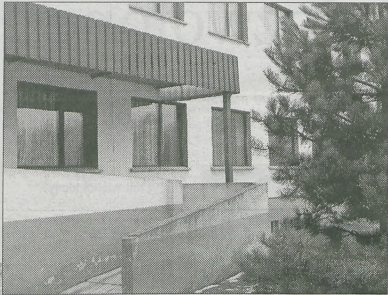
Wnętrze jest remontowane
